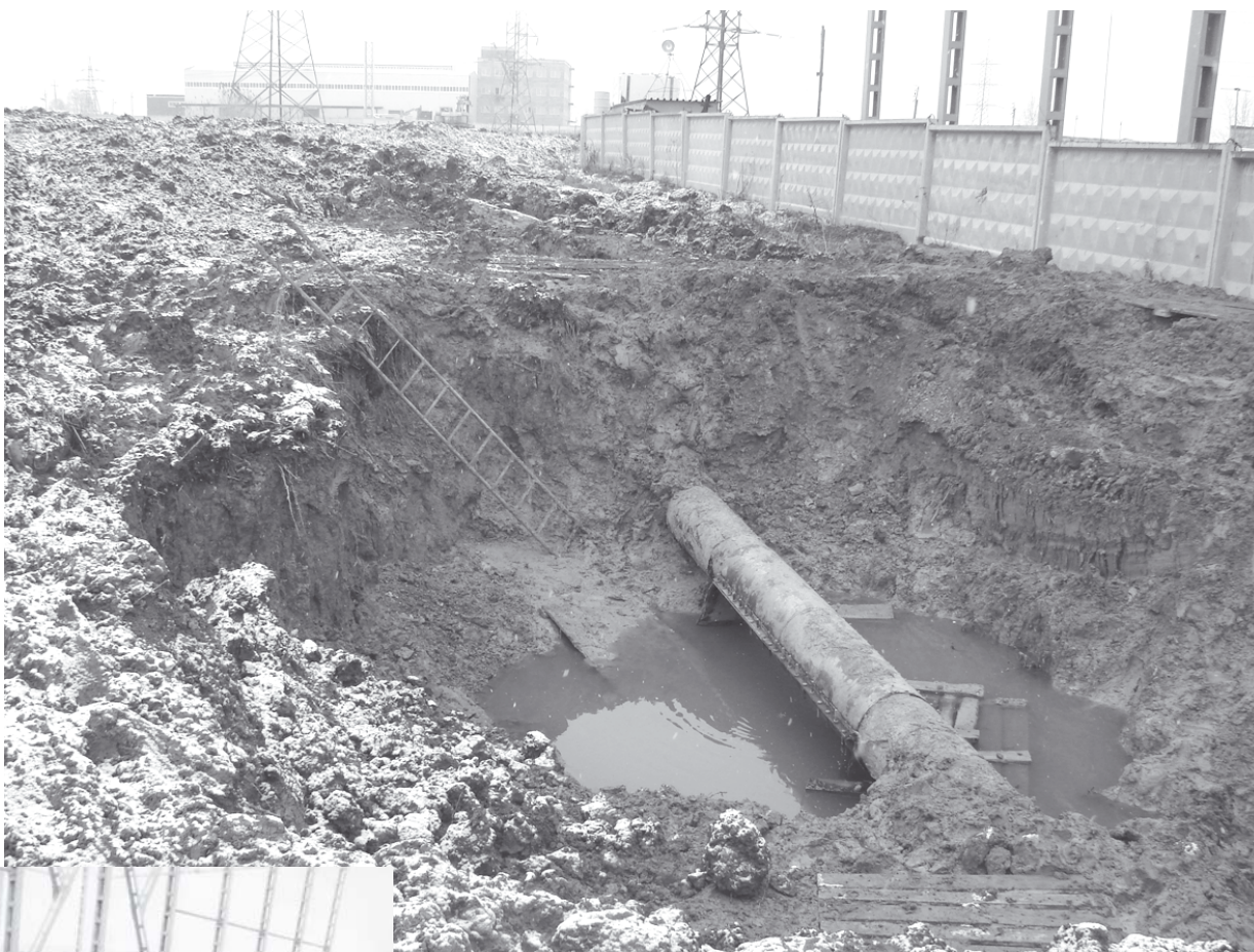
Замененный участок коллектора. Фото 17 марта 2008 г.
