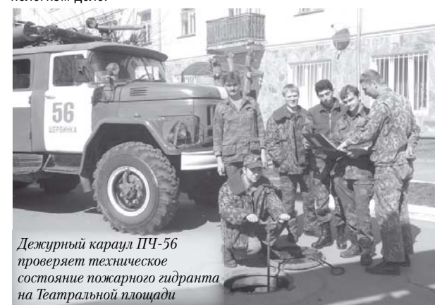
Дежурный караул ПЧ-56 проверяет техническое состояние пожарного гидранта на Театральной площади
