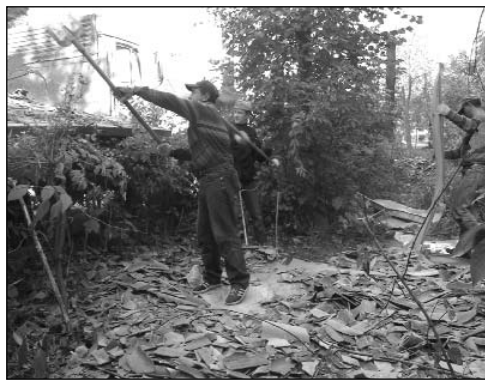
Идут работы по уборке мусора после смены кровли на Почтовой улице, дом 10
