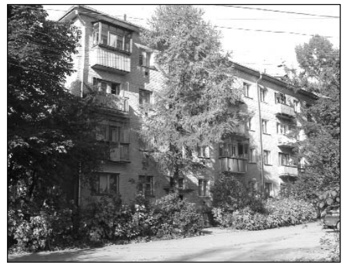
Новая крыша дома № 8 на Почтовой улице
